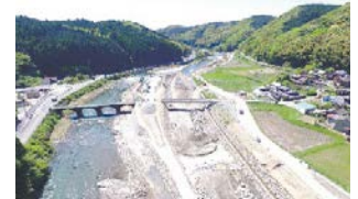
河川の改良工事
